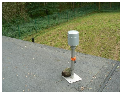
Pose du pluviomètre
