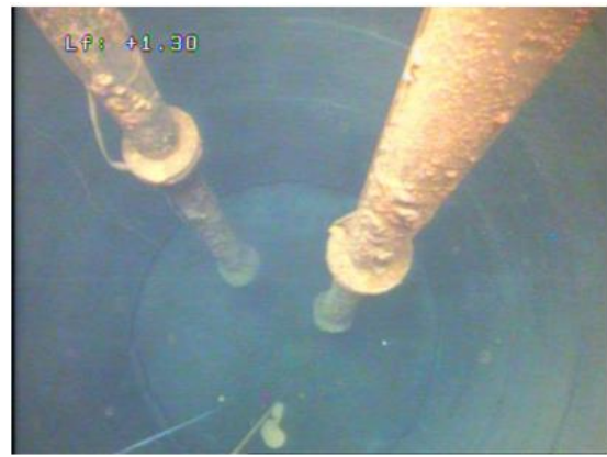
Prof. 1.30 m : vue axiale sur les colonnes de pompes
