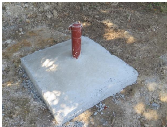
Dalle et protection en tête du piézomètre PZ1
